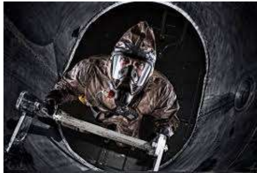
Ilustración 41 Trabajo con riesgo de atmósfera peligrosa
