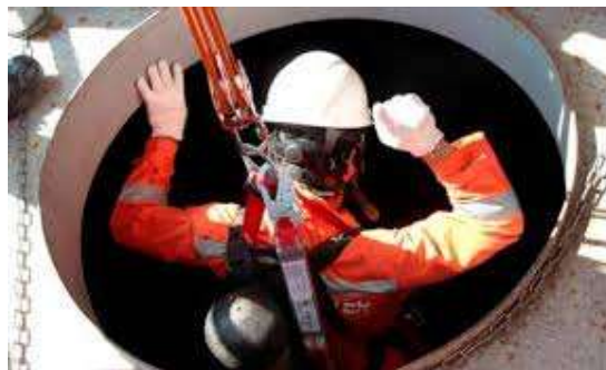
Ilustración 42 Trabajo con acceso limitado
