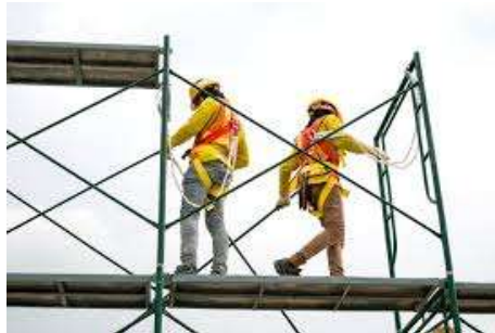
Ilustración 36 Trabajo en andamios
