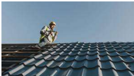
Ilustración 37 Trabajos en cubiertas y tejados
