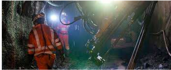
Ilustración 40 Trabajo en espacios confinados
