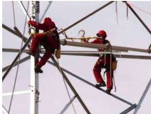
Ilustración 38 Trabajo en torres y escaleras
