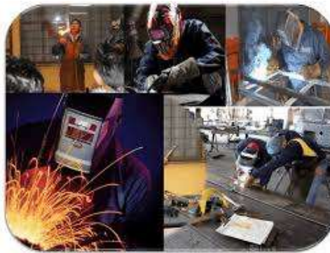
Ilustración 32 Trabajo en soldadura y corte
