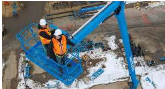
Ilustración 39 Trabajo con plataformas elevadoras
