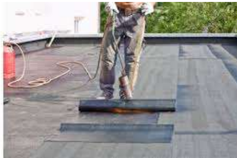
Ilustración 34 Trabajo de impermeabilización con materiales bituminosos
